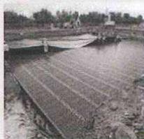
Sono dispositivi con un'alta capacità di detenzione che possono essere usati per creare sotto il terreno strutture in grado di contenere grandi quantità d'acqua o di permettere l'infiltrazione nel terreno.
