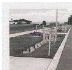
Sono formati da zone depresse lineari di vegetazioni che raccolgono flussi d'acqua da zone impermeabili. Dove possibile, possono essere progettati in modo da consentire infiltrazioni. Possono sostituire i sistemi convenzionali di drenaggio dell'acqua.
