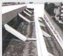
I tetti verdi sono sistemi multistrato permeabili sopra uno strato drenante che possono ricoprire con vegetazione i tetti degli edifici, piattaforme, parcheggi. Sono progettati per intercettare e trattenere l'acqua piovana, attenuando il picchi massimi di deflusso.
